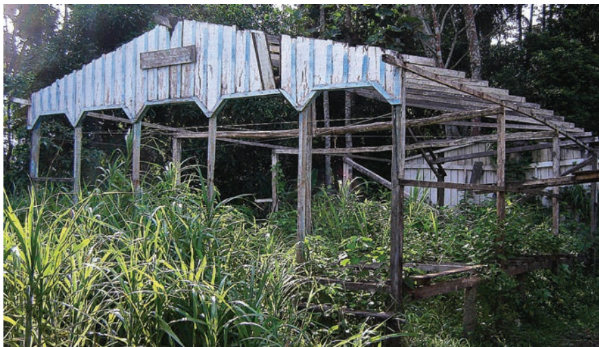
FIGURA 28. ANTIGA SEDE, SITUADA NA ÁREA QUE SOFREU INTENSO DESBARRANQUEAMENTO.
