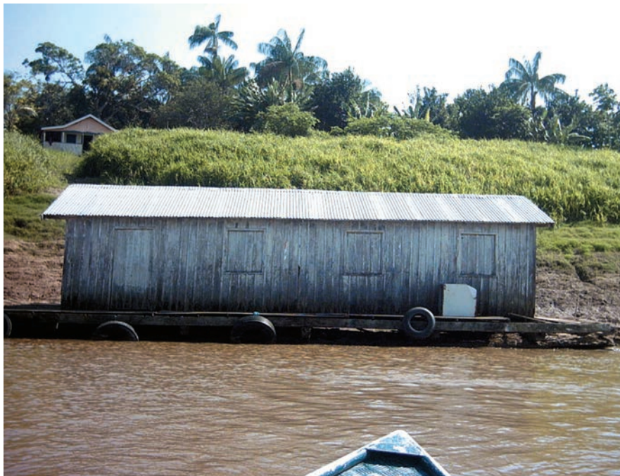
FIGURA 10. FLUTUANTE (CASA DE GERADOR).
