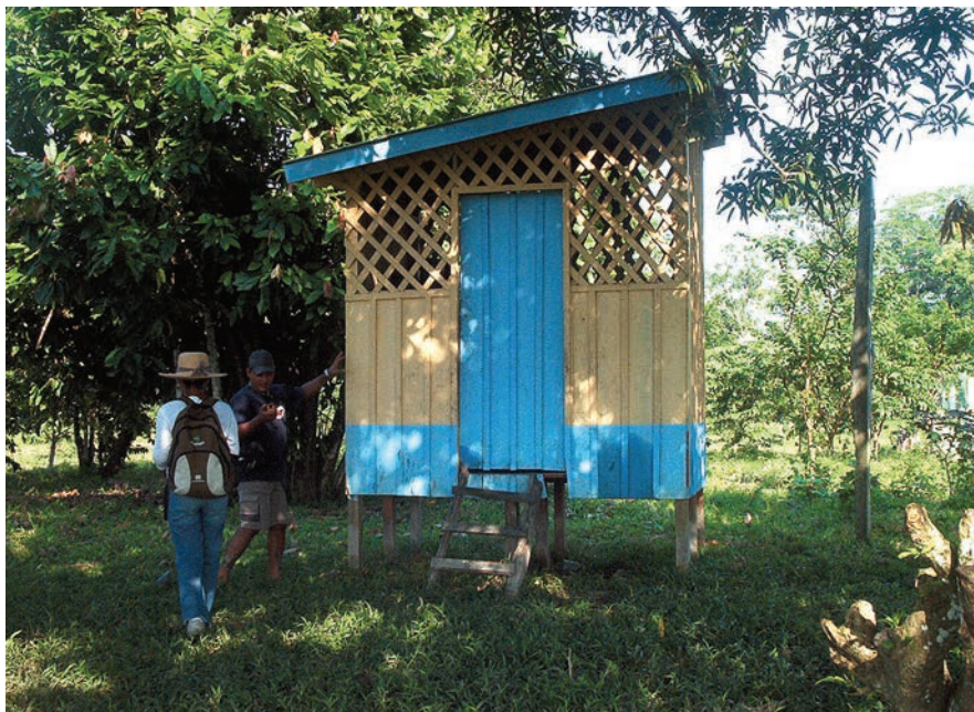
FIGURA 11. CASA DE GERADOR.
