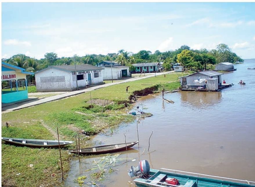
FIGURA 9. CENTRO DA COMUNIDADE LAURO SODRÉ, À ESQUERDA ESTÁ O CENTRO SOCIAL, AO LADO DO CENTRO SOCIAL, A CASA DO SOM COMUNITÁRIO. Fonte: Núcleo de Socioeconomia, Projeto Platam, junho de 2005.
